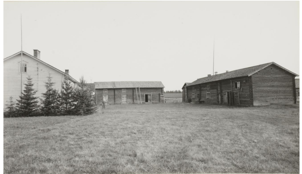
Kuva 86. Lamminahon pihapiiri vuonna 1978. (Kuva Veijo Laine / Museovirasto / Rakennushistorian kuvakokoelma).
