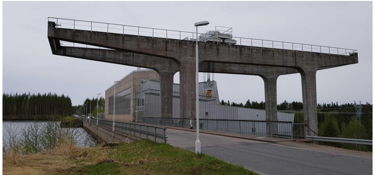
Kuva 36. Nuojuan voimalaitos, näkymä patosillalle kaakon suuntaan.
