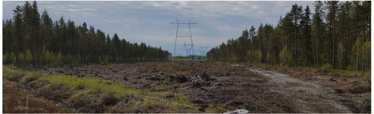
Kuva 28. Rakenteilla oleva voimalinja Nuojuankankaan sähköasemalta pohjoiseen. Näkymä Jylhämäntieltä pohjoisen suuntaan.
