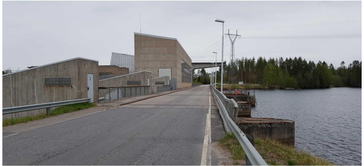
Kuva 35. Nuojuan voimalaitos, näkymä patosillalta luoteeseen.
