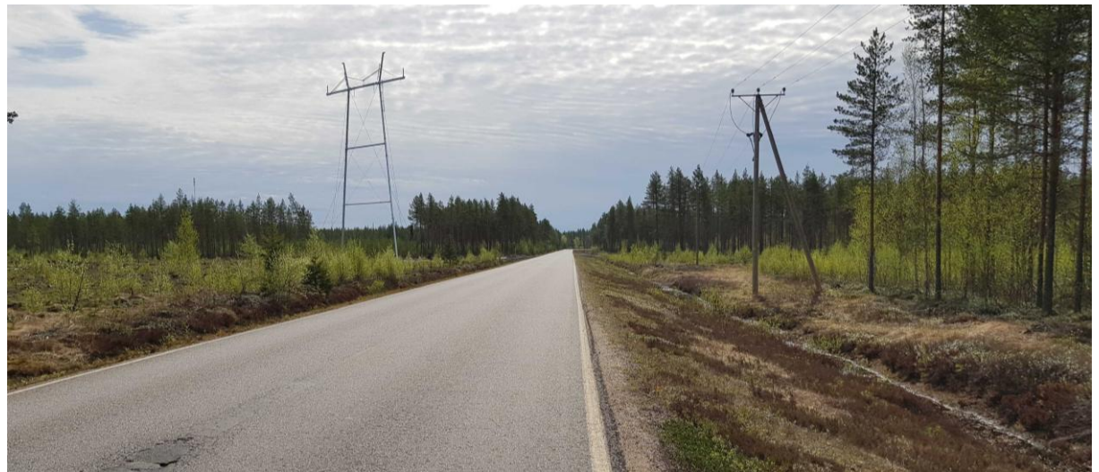
Kuva 25. Jylhämäntie. Kuvassa näkyy myös Nuojuankankaan sähköasemalta pohjoiseen johtava voimalinja. Rakentaminen on vielä kesken, linjalta puuttuvat voimajohdot.
