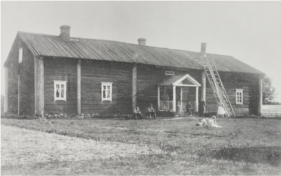
Kuva 84. Lamminahon talo noin vuonna 1910. Valokuvaamo Hynninen, Kajaani. (Kuva Museovirasto / Rakennushistorian kuvakokoelma).
