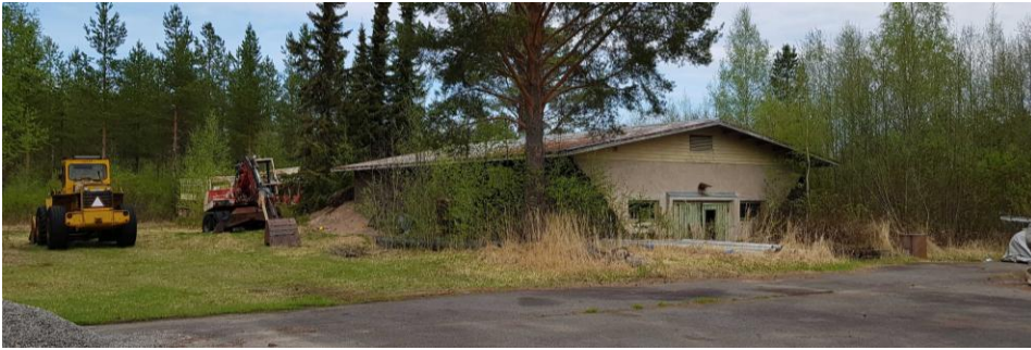
Kuva 68. Varastorakennus konttori-ruokalarakennuksen luoteispuolella.
