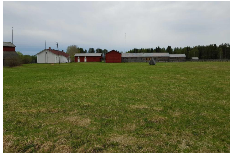
Kuva 91. Lamminahon pihapiiri vuonna 2026.
