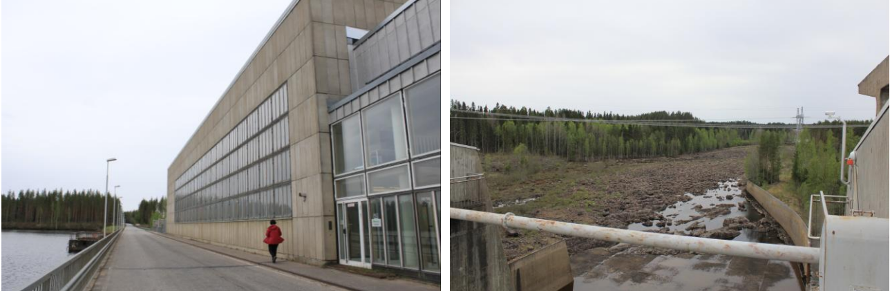
Kuvat 30 ja 31. Nuojuan vesivoimalaitos.
