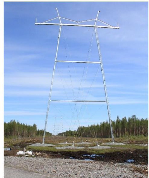
Kuva 34. Rakenteilla oleva Petäjäskoski–Nuojuankangas-voimajohto kulkee osin kaava-alueella.
