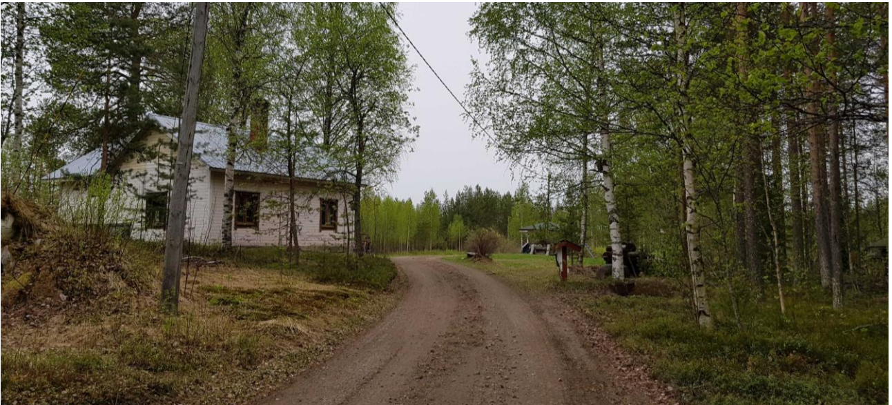
Kuva 26. Asuinrakennus Syrjäläntien varrella sijaitsee kaava-alueen rajalla alueen koillispuolella.
