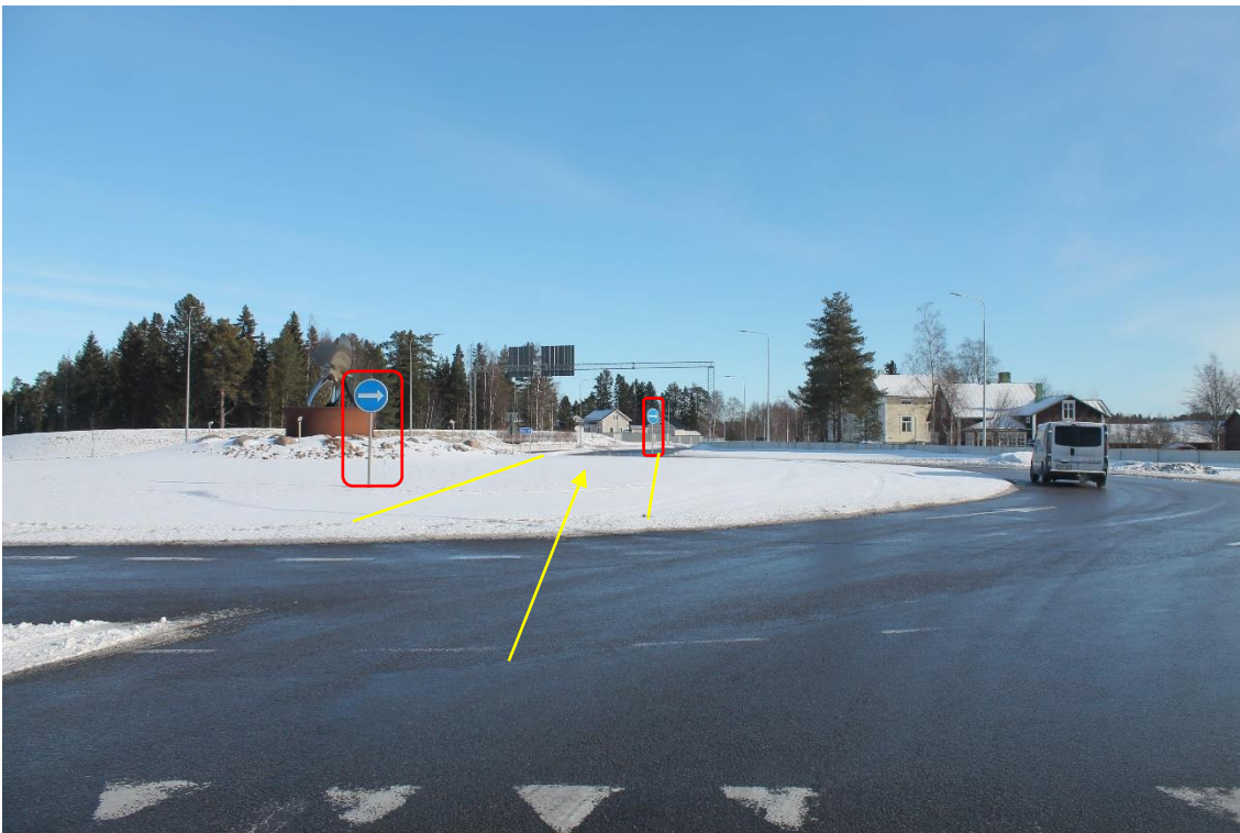
Sijainti 9/Kuva 20. Liikenneympyrä tiellä 8. Jatka suoraan. https://goo.gl/maps/QUW3nz9bApAtpjiRA . Merkitty alue tulee tasoittaa ja täyttää, jotta siitä voidaan ajaa. Merkityt liikennemerkit poistettava.
