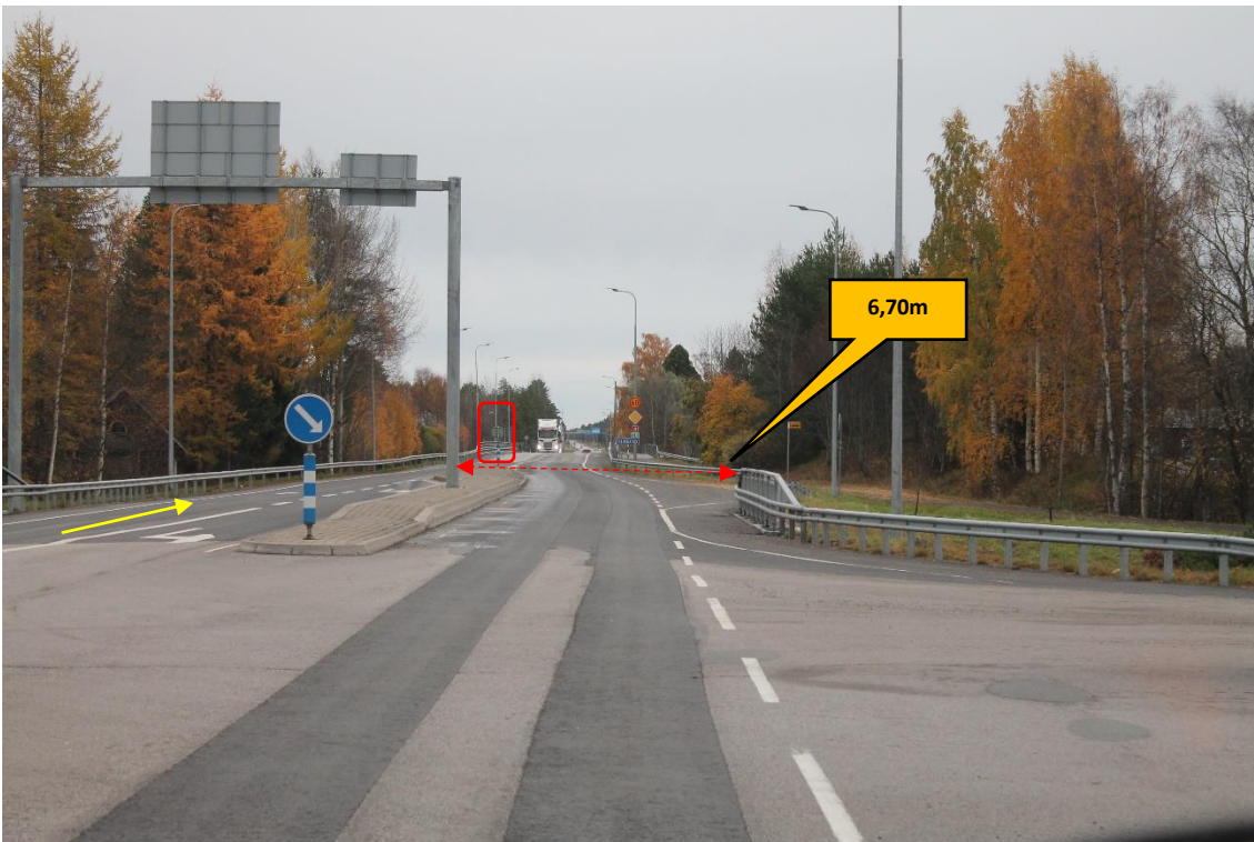
Sijainti 12/Kuva 26. Tie 8. https://goo.gl/maps/fLBJdYMTxjLyqj1Z9 . Käytettävä vastaan tulijoiden kaistaa. Merkitty liikennemerkki poistettava.
