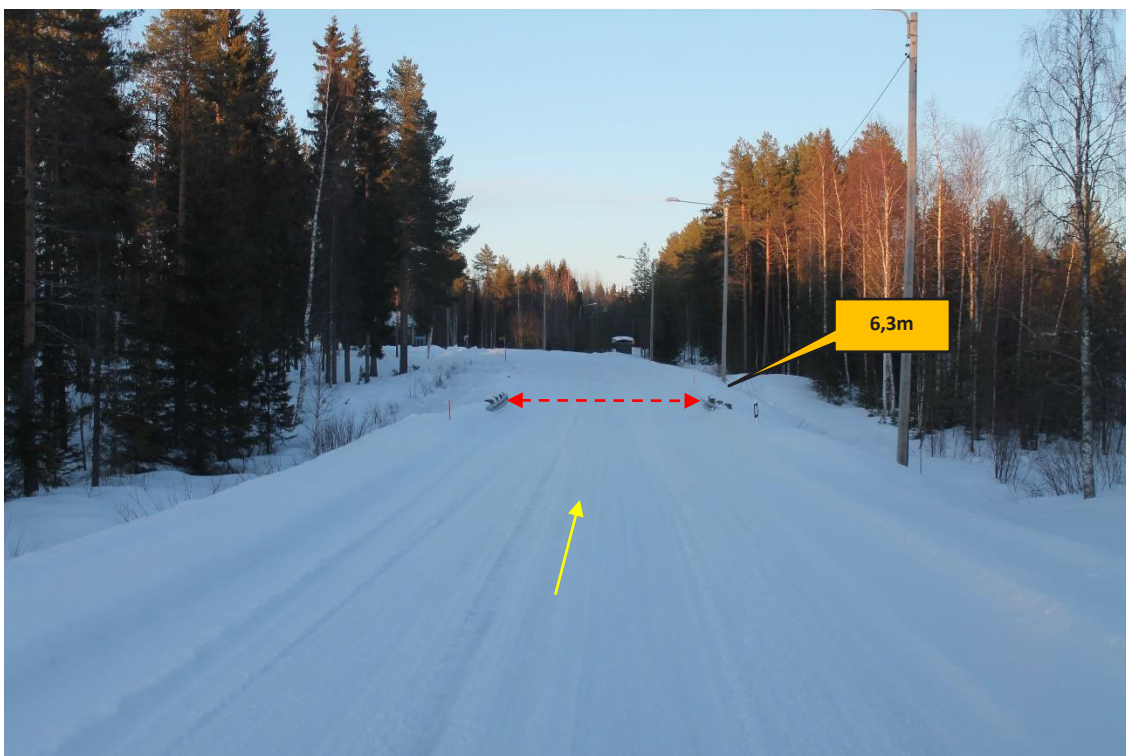
Sijainti 64/Kuva 132. Tie 8832 (Puukiontie). https://goo.gl/maps/dESvqTWuKwoKTb3V9 Pieni silta, jonka kantokapasiteetti on tarkistettava.
