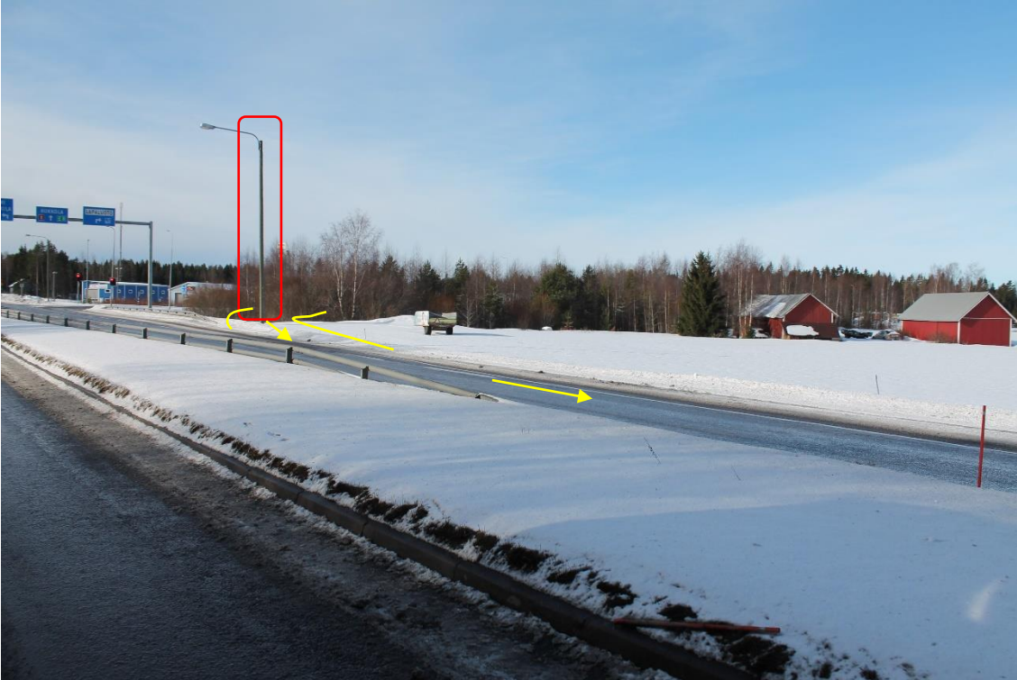
Sijainti 8/Kuva 17. Käänös Lapaluodontieltä tielle 8. https://goo.gl/maps/gEXrYehRWmLhJZ8g6 . Uusi tie on rakennettava risteysalueen läpi kulkemiseksi. Tien rakennusalue yksityisomistuksessa. Merkitty lyhtypylväs poistettava.
