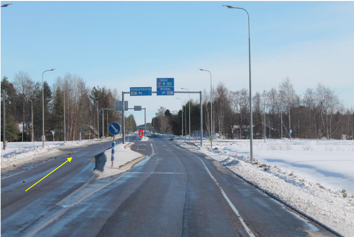
Sijainti 12/Kuva 25. Tie 8. Jatka suoraan. https://goo.gl/maps/fLBJdYMTxjLyqj1Z9 . Käytettävä vastaan tulijoiden kaistaa. Merkitty liikennemerkki poistettava.
