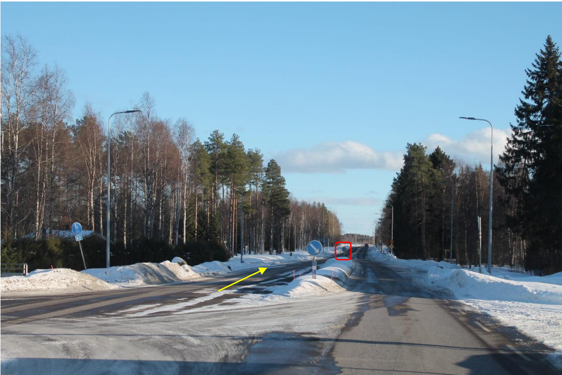
Sijainti 49/Kuva 108. Tie 22. Käytettävä vastaantulijoiden kaistaa. Merkitty liikennemerkki poistettava.
