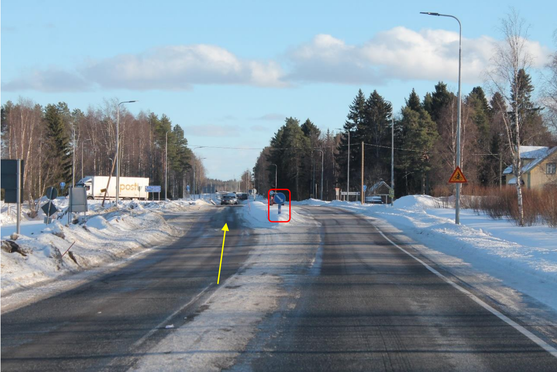
Sijainti 49/Kuva 107. Tie 22. https://goo.gl/maps/GusprQZC1ZVLnAKN9 Käytettävä vastaantulijoiden kaistaa. Merkitty liikennemerkki poistettava.
