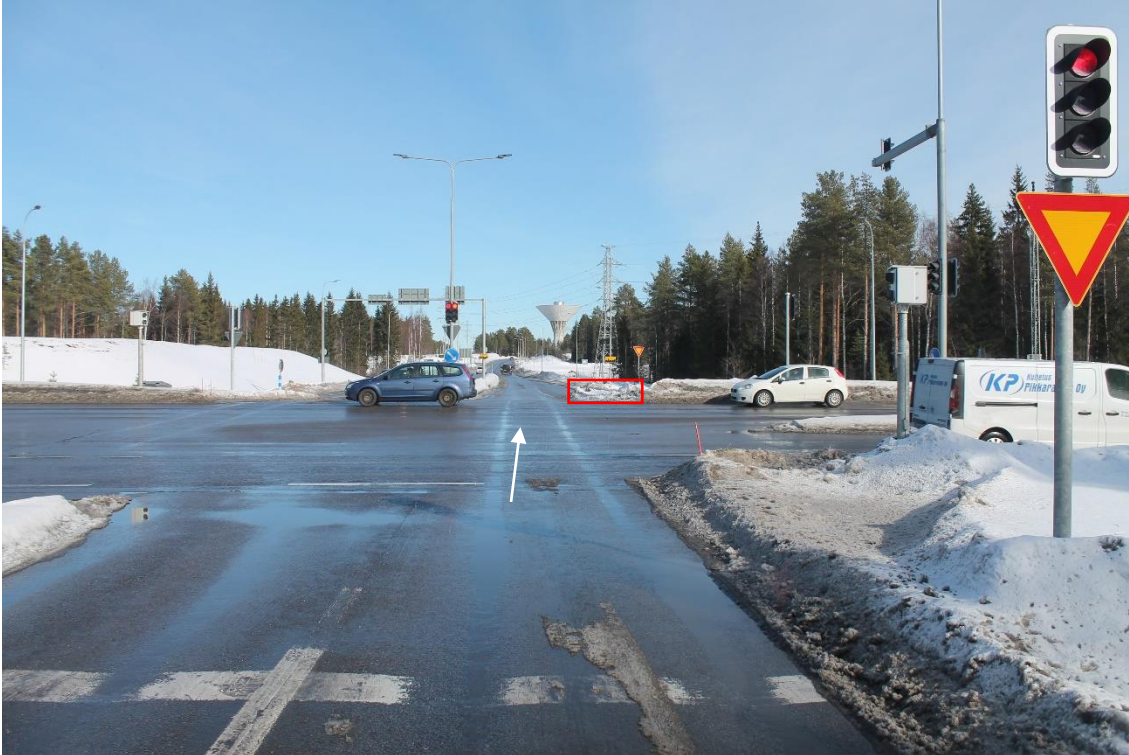
Sijainti 24/Kuva 55. Poikkimaantie (tie 8155). Reitti 1. Ajourien välissä terävä harjanne. Maavara tarkastettava kuljetusten aikana. Merkitty lumikinos tulee siirtää talviaikaan.
