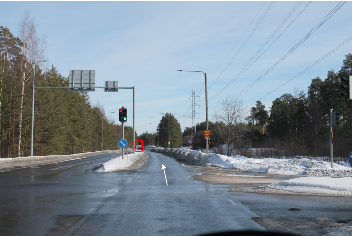
Sijainti 23/Kuva 52. Käännös tieltä 4 kohti Poikkimaantietä (tie 8155). Reitti 1. https://goo.gl/maps/tENSwwJ7kYBnT7Fp6 Merkitty liikennemerkki tulee poistaa.
