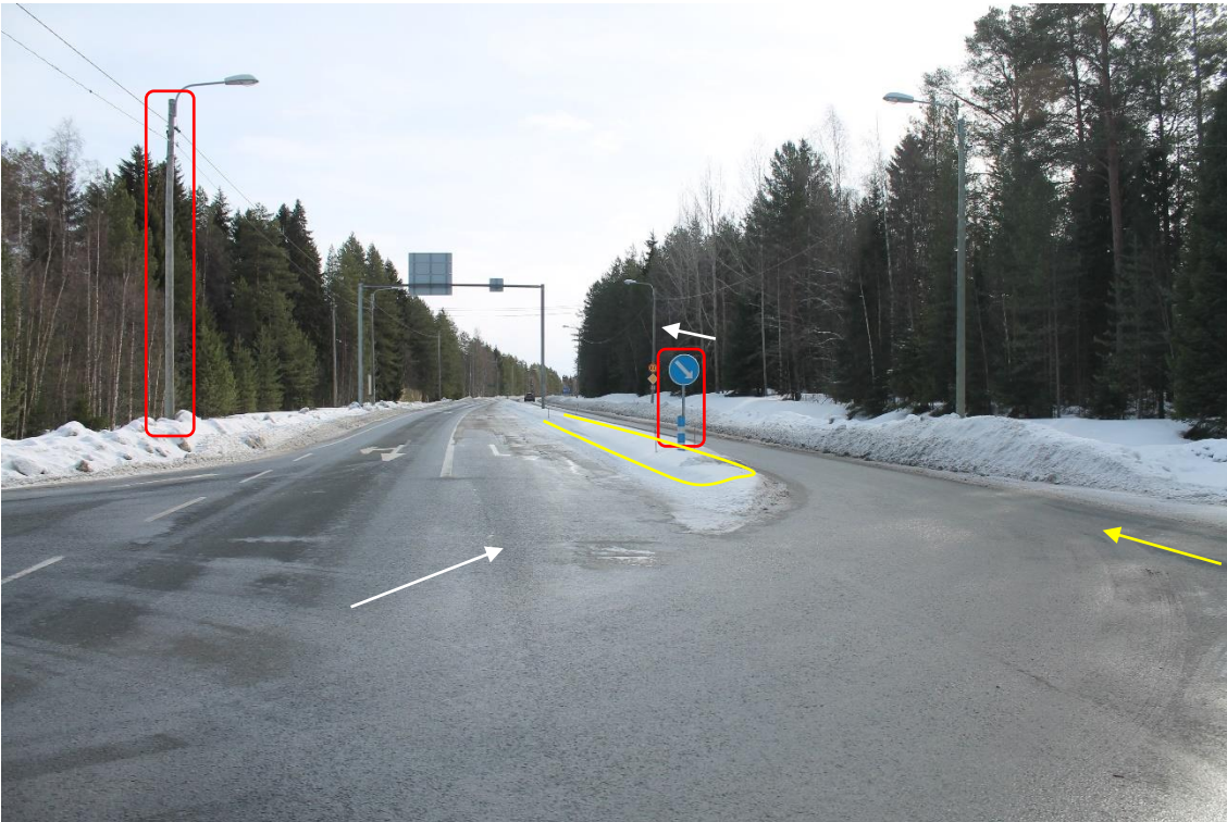
Sijainti 34/Kuva 74. Käännös tieltä 18693 kohti tietä 22. Reitti 1. Merkityt liikennemerkit ja lyhtypylväs poistettava. Merkitty alue tulee tasoittaa, jotta siitä voidaan ajaa. Tästä eteenpäin siivet kuljetetaan samalla reitillä.
