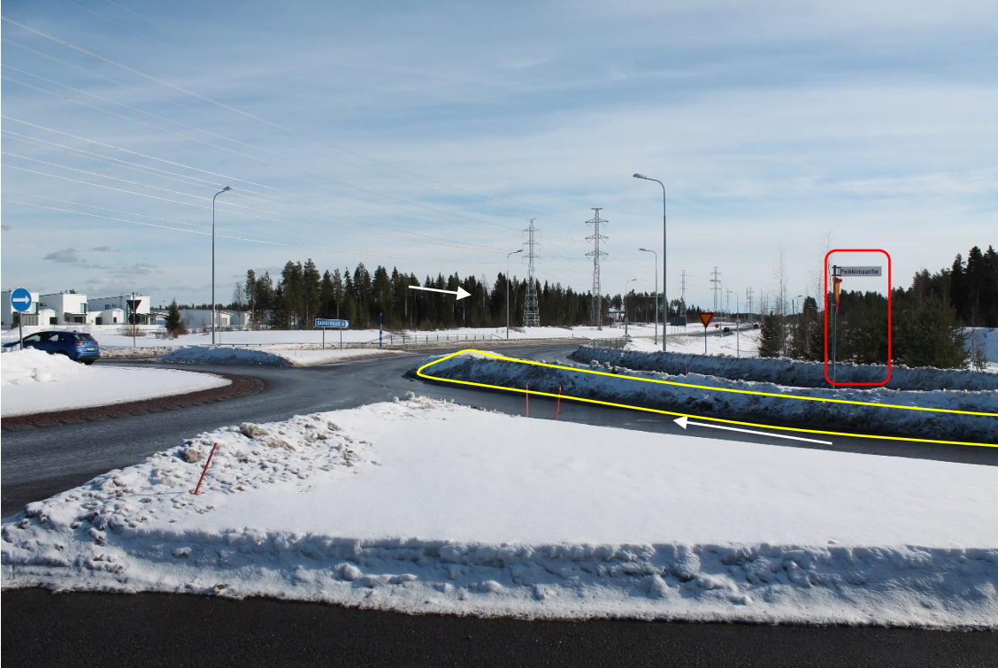
Sijainti 26/Kuva 61. Käännös Poikkimaantieltä (tie 8155) kohti tietä 8300. Reitti 1. Merkityt liikennemerkit tulee poistaa. Merkitty alue tulee tyhjentää sivuylityksen takia.
