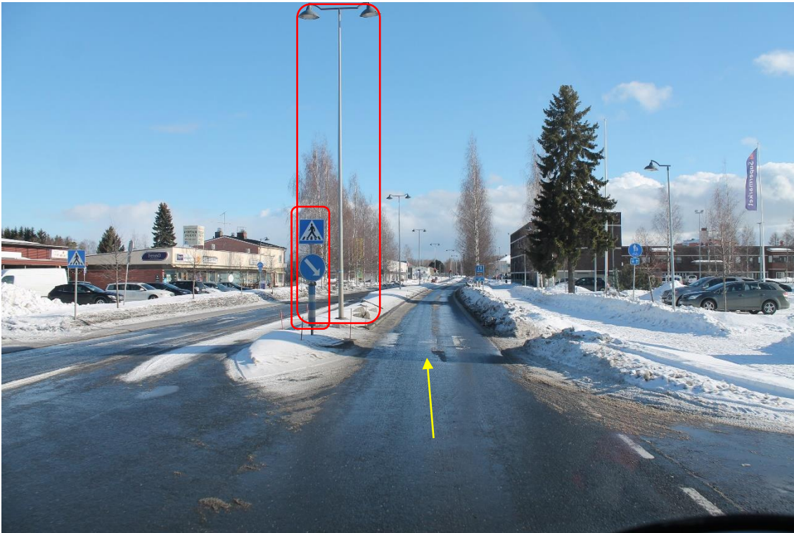
Sijainti 43/Kuva 95. Tie 22. https://goo.gl/maps/WQLM7eaYZ5pnFMqU7 Merkityt liikennemerkki ja lyhtypylväs poistettava.
