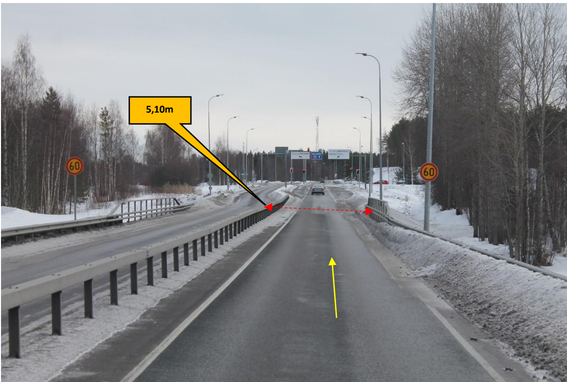
Sijainti 37/Kuva 84. Tie 22. Reitti 2. Sillan kantokapasiteetti tarkastettava.
