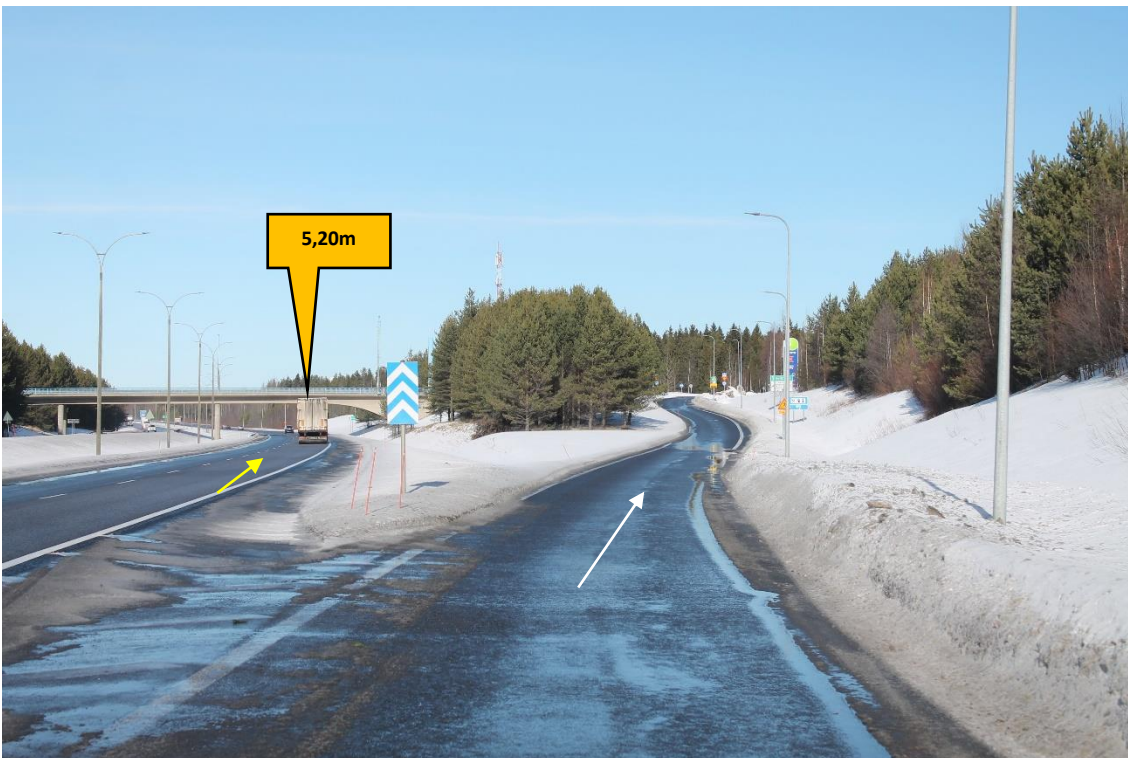
Sijainti 20/Kuva 40. Tie 4. Siipien kuljetus suoraan tiellä 4 sillan alta. Korkeat lastit kuljetetaan liittymäramppien kautta. https://goo.gl/maps/vjM7atAyhSsGFUFW8
