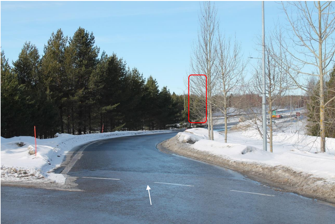
Sijainti 20/Kuva 43. Tien 4 ramppi: Ouluntulli. Korkeat lastit kuljetetaan liittämärampin kautta. Merkityt puunoksat tulee leikata.
