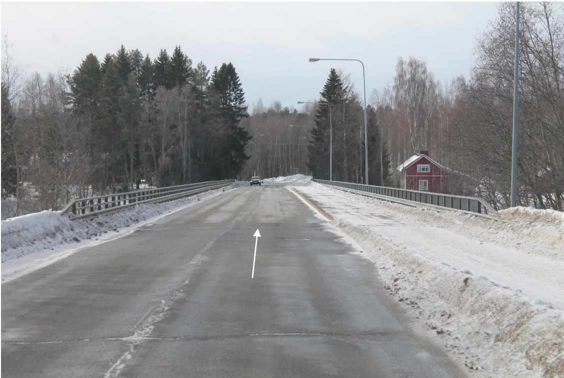
Sijainti 31/Kuva 69. Tie 18693. Reitti 1. https://goo.gl/maps/XFqVDe3qBt4NP5jB9 Sillan kantokapasiteetti tarkistettava.
