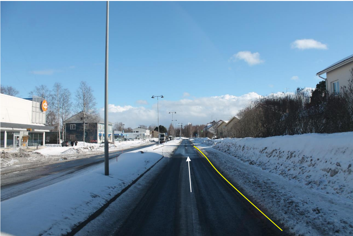
Sijainti 44/Kuva 98. Tie 22. Merkityt alueet tien sivussa tasoitettava ja täytettävä.
