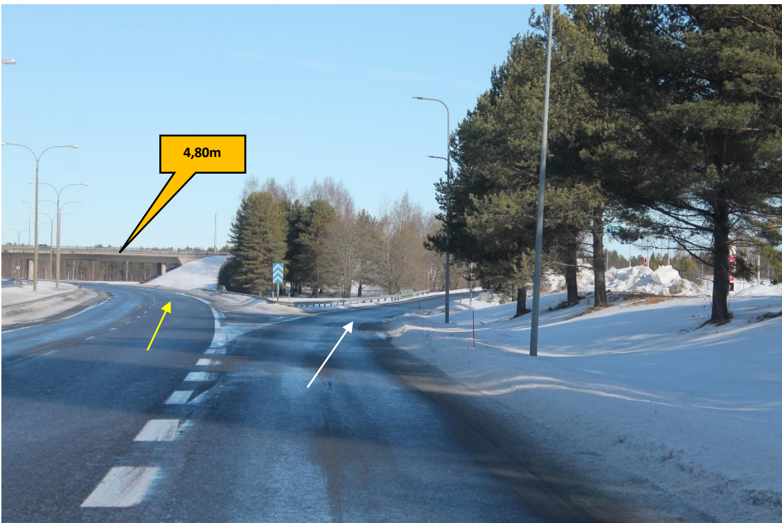
Sijainti 19/Kuva 36. Tie 4. Siipien kuljetus suoraan tiellä 4 sillan alta. Korkeat lastit kuljetetaan liittymärampin kautta. https://goo.gl/maps/Vz6z5dDq667ThFP58
