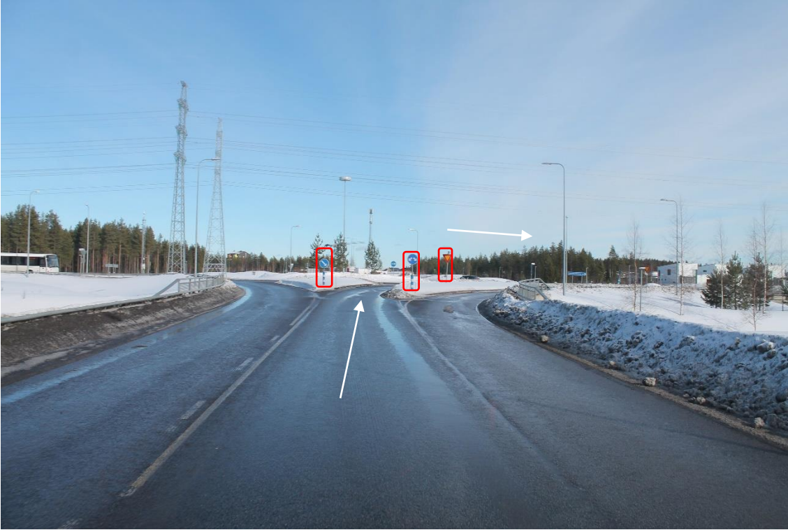
Sijainti 25/Kuva 59. Käännös Poikkimaantieltä (tie 8155) kohti tietä 8300. Reitti 1. https://goo.gl/maps/VjcqLrqYpRQmMtTC8 Merkityt liikennemerkit tulee poistaa.
