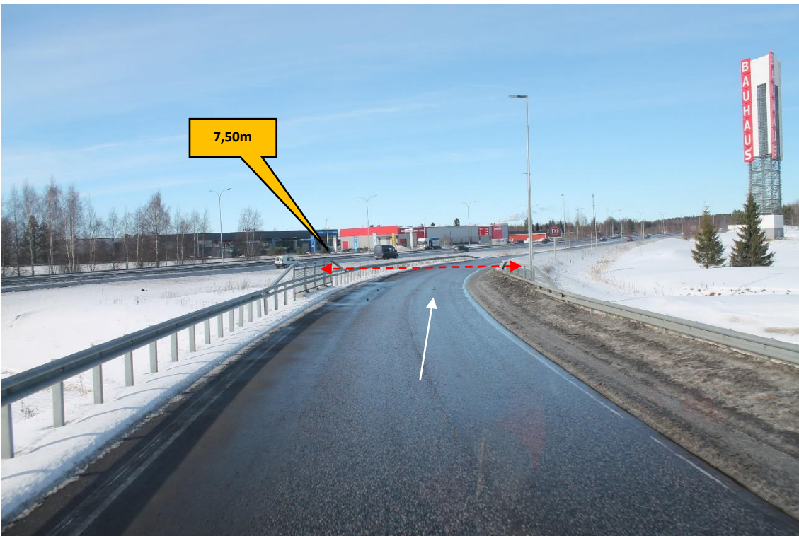
Sijainti 21/Kuva 48. Tien 4 ramppi: Kaakkuri. Korkeat lastit kuljetetaan liittymäramppien kautta. https://goo.gl/maps/zSxkqiGSATJj74ke7 . Tieaidan korkeus vasemmalla 1,32 m ja oikealla 1,25 m.
