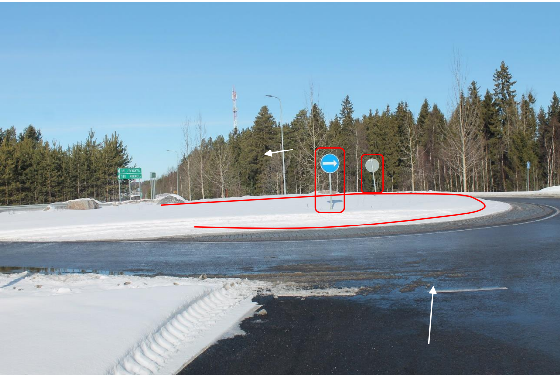
Sijainti 20/Kuva 42. Tien 4 ramppi: Ouluntulli. Korkeat lastit kuljetetaan liittymäramppien kautta. https://goo.gl/maps/vjM7atAyhSsGFUFW8 Merkityt lyhtypylväät ja liikennemerkit on poistettava. Liikenneympyrän sisäinen merkitty alue tulee tasoittaa ja tyhjentää sivuylityksen takia.
