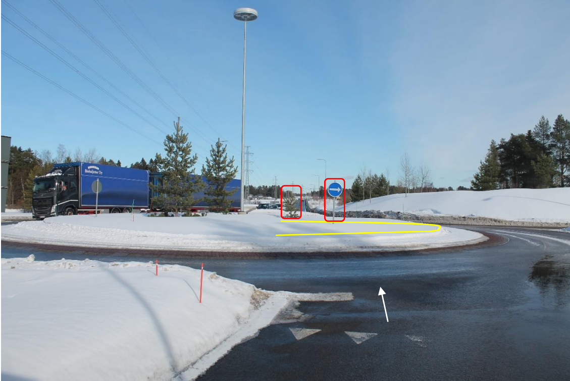
Sijainti 25/Kuva 57. Poikkimaantien liikenneympyrä (tie 8155). Reitti 1. Liikenneympyrän sisäosa tulee tyhjentää ja tasoittaa sivuylityksen takia. Merkitty liikennemerkki poistettava. Merkitty puu kaadettava.
