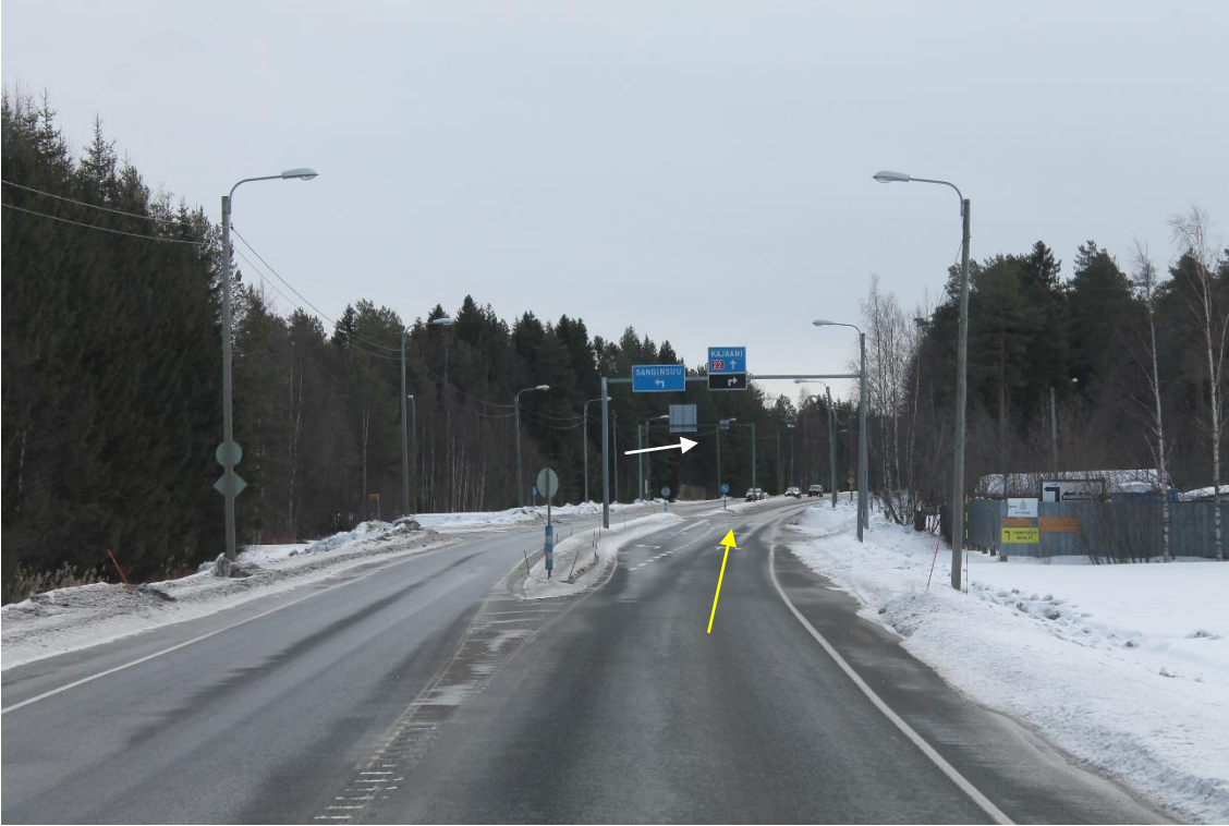
Sijainti 34/Kuva 85. Tie 22. https://goo.gl/maps/eReicGAjtCDBea1S6 Siipien ja runkojen reitit yhdistyvät.
