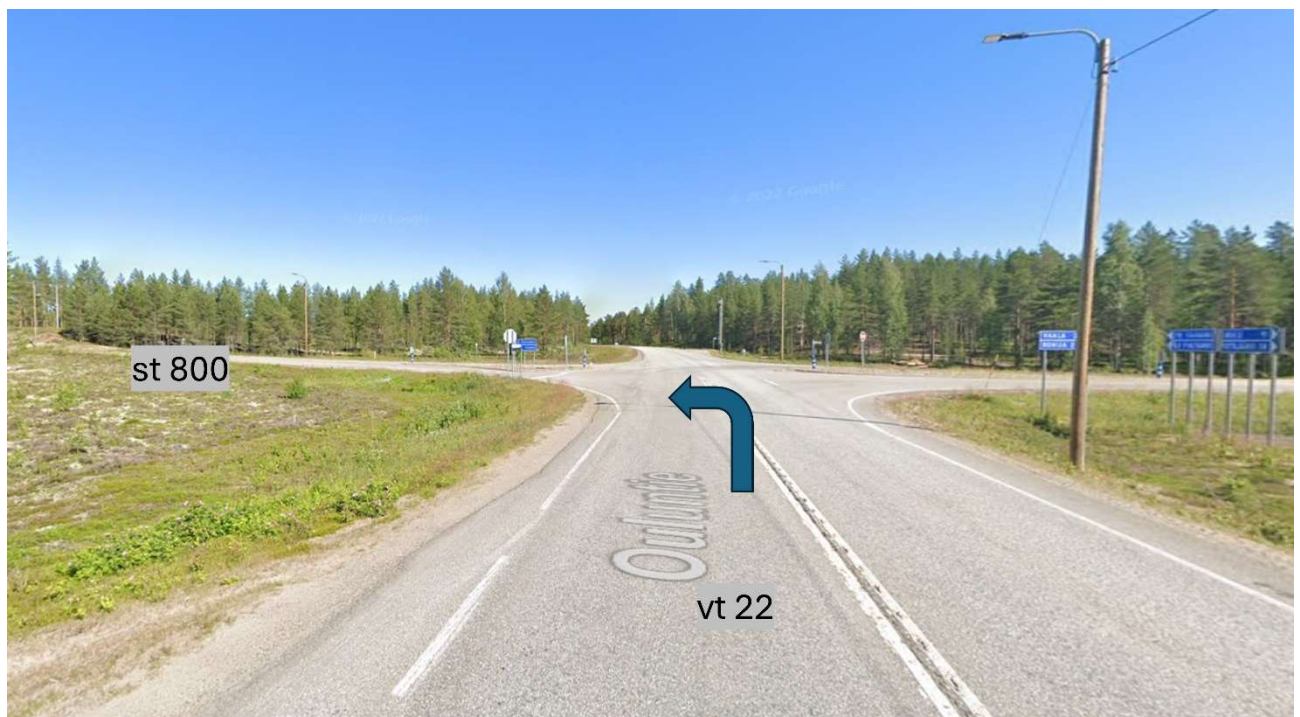
Kuva 6: Valtatien 22 ja seututien 800 liittymä, tulppaliittymä
