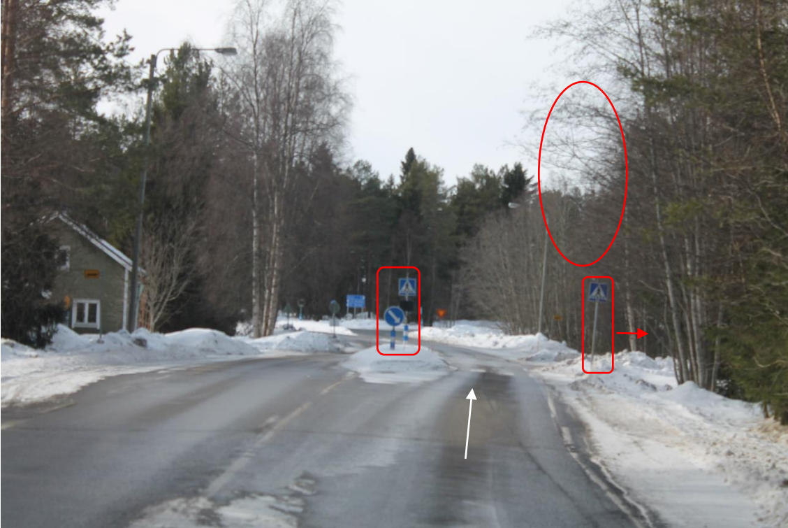
Sijainti 33/Kuva 71. Tie 18693. Reitti 1. https://goo.gl/maps/cQuAfaFnNxMhaxgh8 Merkityt liikennemerkit siirrettävä tai poistettava. Merkityt oksat leikattava.
