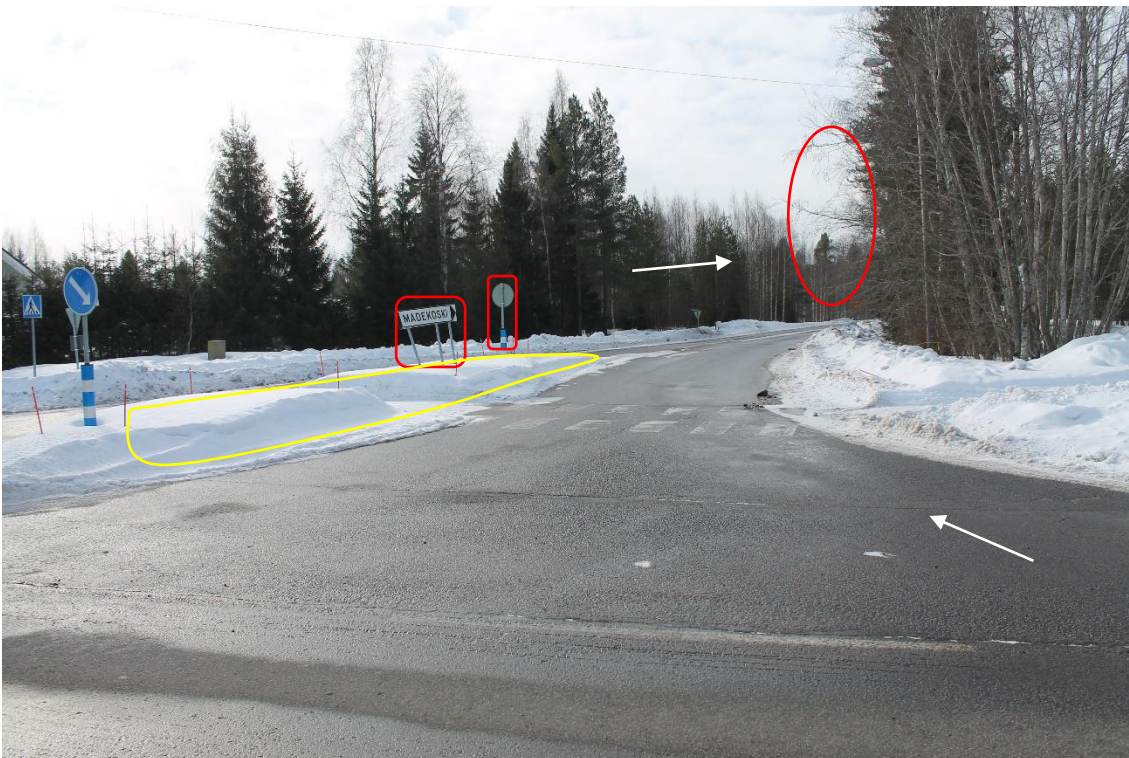
Sijainti 30/Kuva 68. Käännös tieltä 8300 kohti tietä 18693. Reitti 1. Merkityt liikennemerkit tulee poistaa. Merkitty alue tulee tasoitta, jotta sen päältä voidaan ajaa. Merkityt oksat tulee leikata.
