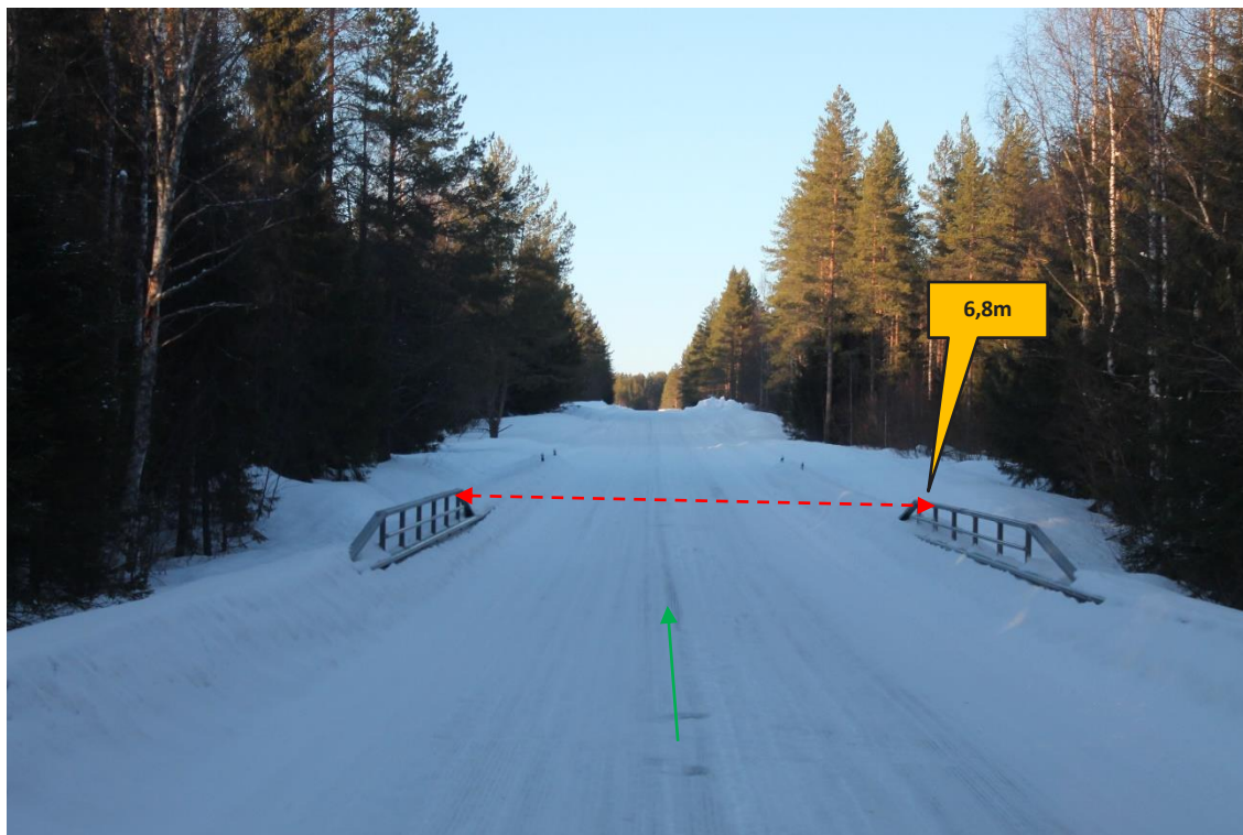
Sijainti 54/Kuva 115. Tie 800. https://goo.gl/maps/oWMqanzexuNRABgV9 Sillan kantokapasiteetti tarkistettava.
