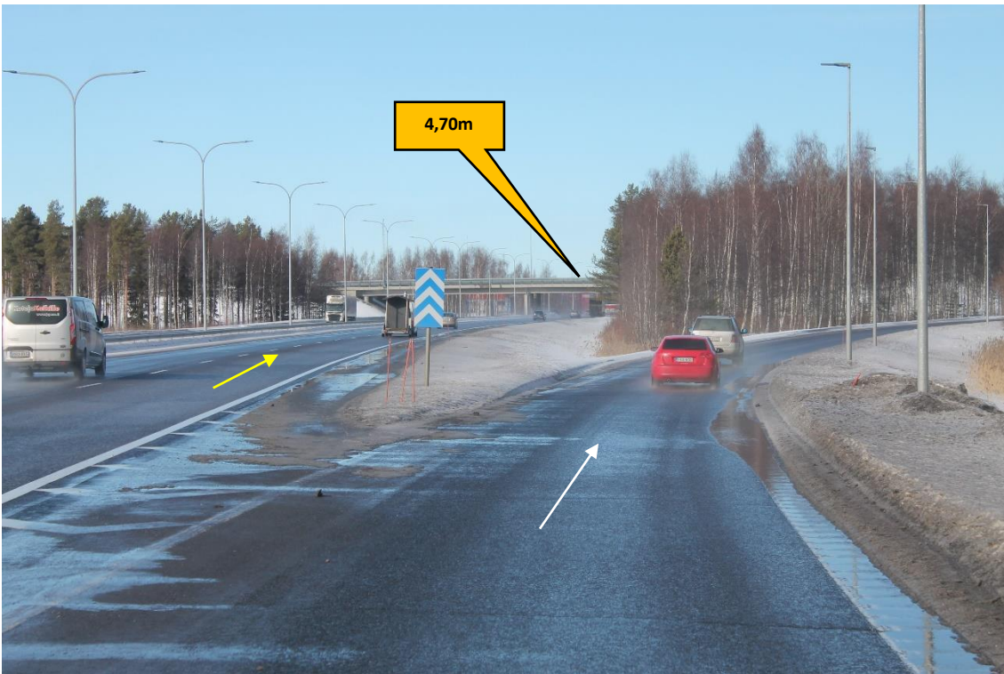
Sijainti 21/Kuva 44. Tie 4. Siivet kuljetetaan suoraan sillan ali. https://goo.gl/maps/zSxkgiGSATJj74ke7 . Korkeat lastit kuljetetaan liittämärampin kautta.
