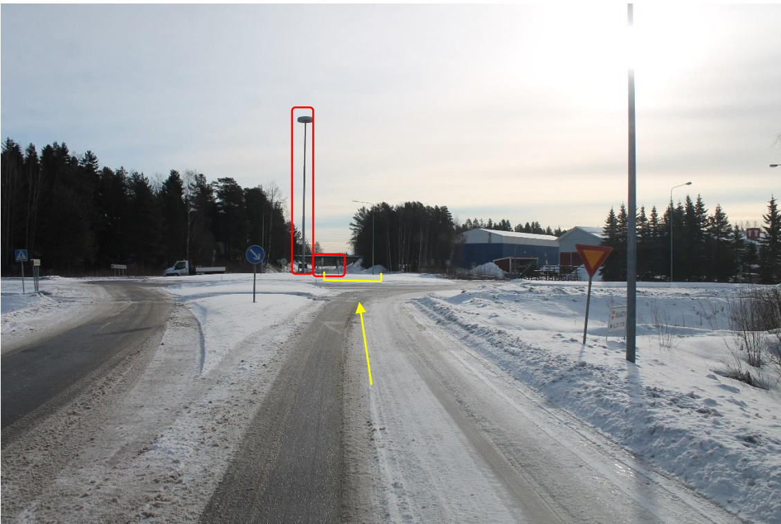
Sijainti 6/Kuva 10. Lapaluodontien liikenneympyrä. https://goo.gl/maps/fNoSyewtX85WBptj7 . Lyhtypylväs ja liikennemerkki poistettava. Merkitty alue tulee täyttää, jotta siitä voidaan ajaa.
