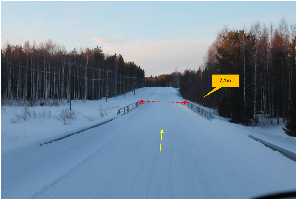
Sijainti 69/Kuva 137. Tie 8832 (Puokiontie). https://goo.gl/maps/JfLXdNkF3PohNENF6 Sillan kantokapasiteetti tarkistettava.
