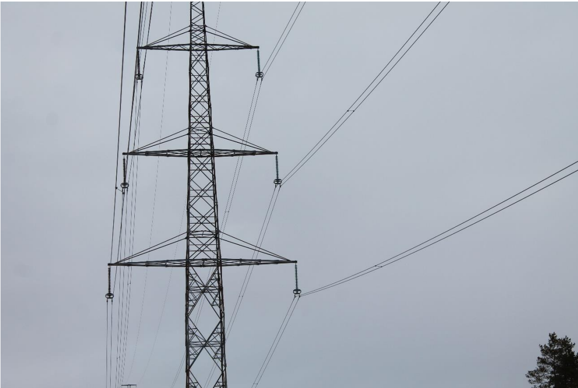
Sijainti 38/Kuva 86. Tie 22. https://goo.gl/maps/cSBx7RsPE7TWr8x76 Fingrid-sähkölinja 400kV. Mitattu korkeus 11,20 m, kun lämpötila -1 celsiusastetta. Kuljetusten maksimikorkeus ilman linjan muutoksia on 6,20 m.
