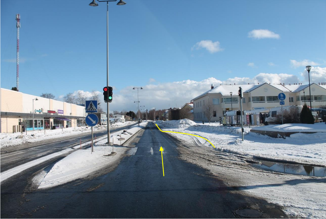
Sijainti 44/Kuva 97. Tie 22. https://goo.gl/maps/ms6v9nhB7o9TB5C38 Merkityt alueet tien sivussa tasoitettava ja täytettävä.
