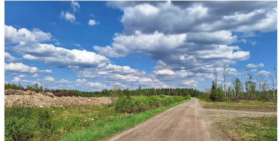
Näkymä vedenpuhdistamon rakennuksen kohdalta Puhdistamontieltä. Tien oikealle puolelle jäävät jätevedenpuhdistamon vesialtaat, vasemmalle käytössä oleva maanlajitysalue.
