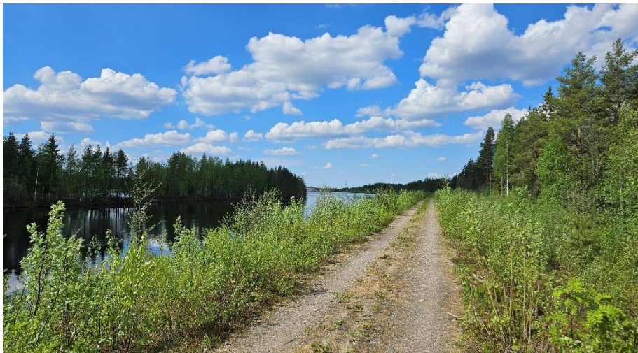
Kuva suunnittelualuetta reunustavan padon päältä kohti pohjoista. Jokinäkymän päätteessä näkyy Jylhämän voimalaitos.
