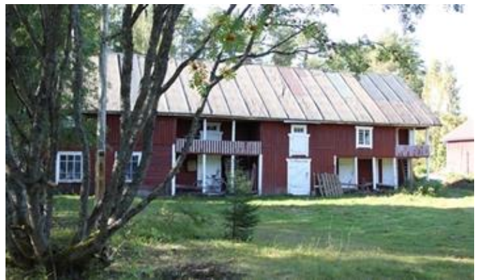
Aittaliiteri 1900-luvun alusta Kirsti Reskalenko 5.9.2017
