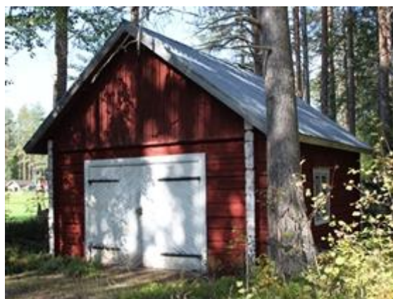
Hirsirakenteinen autotalli Kirsti Reskalenko 5.9.2017
