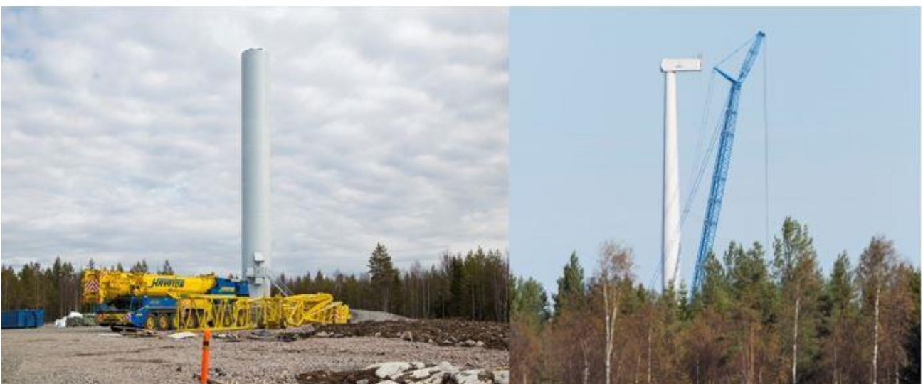
Kuva 5.13. Tuulivoimalan kokoamista (Ville Suorsa, FCG).
