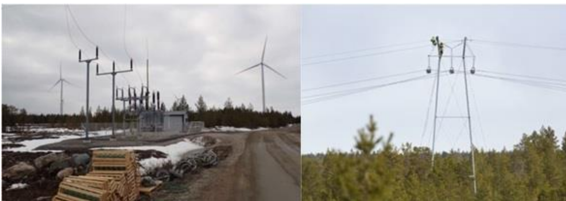
Kuva 5.15. Sähköaseman ja voimajohdon rakentamista (Ville Suorsa, FCG).
