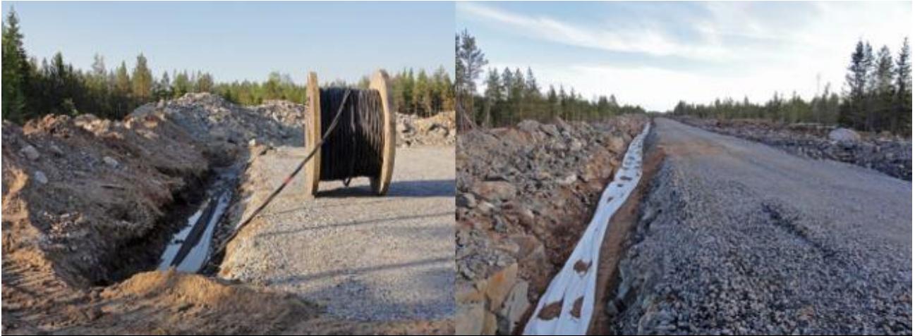
Kuva 5.11. Maakaapelit upotetaan huoltoteiden yhteyteen (Ville Suorsa, FCG).
