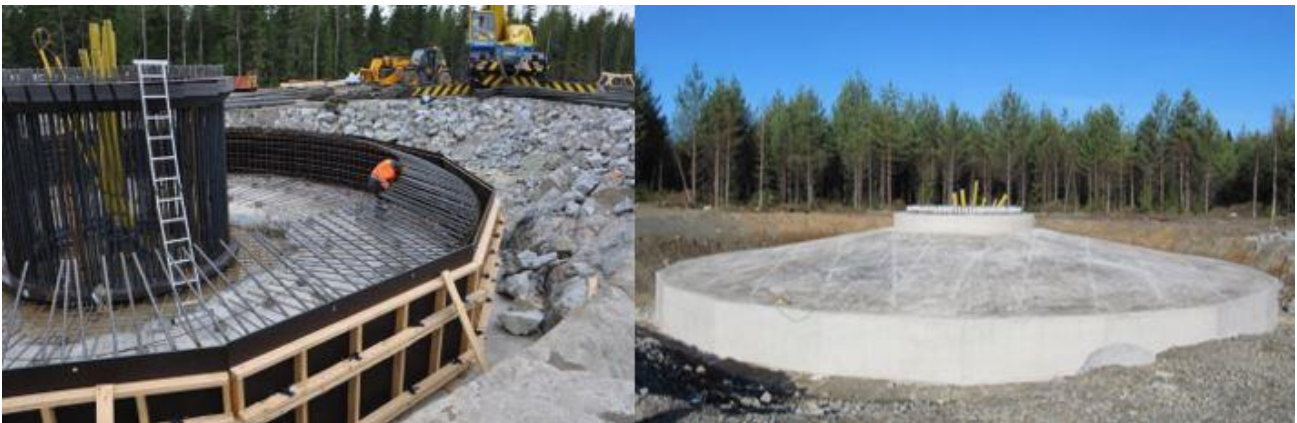
Kuva 5.12. Tuulivoimalan perustusten rakentamista (Leila Väyrynen, FCG).
