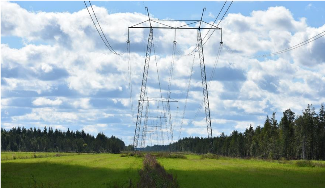
Kuva 17. Hankealueelle sijoittuu Fingridin 400 kV voimajohto Pyhänselkä-Vuolijoki (FCG / Minna Takalo).
