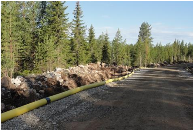
Kuva 72. Vasemmallä kuvassa on esimerkki tuulivoimapuiston rakennus- ja huoltotiestä. Teitä käytetään muun muassa betonin, soran ja voimaloiden komponenttien kuljetuksiin sekä tuulivoimapuiston käyttövaiheessa huoltoajoihin. Maakaapeli sijoitetaan ojakaivantoon tien reuna-alueelle. Oikealla kuvassa tuulivoimalan osia kuljetetaan erikoiskuljetuksina. (Kuvat: Ville Suorsa / FCG).
