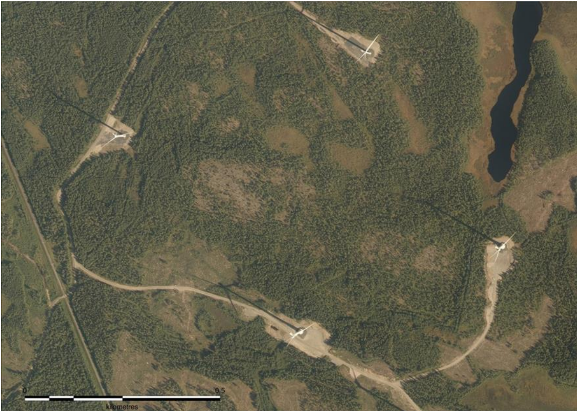
Kuva 66. Ilmakuvassa näkyy toiminnassa olevia tuulivoimaloita. Tuulivoimaloita varten on rakennettu huoltotiet ja nostokentät. Tuulivoimaloiden ympäristössä ja välialueilla aikaisempi maankäyttö on säilynyt ennallaan.
