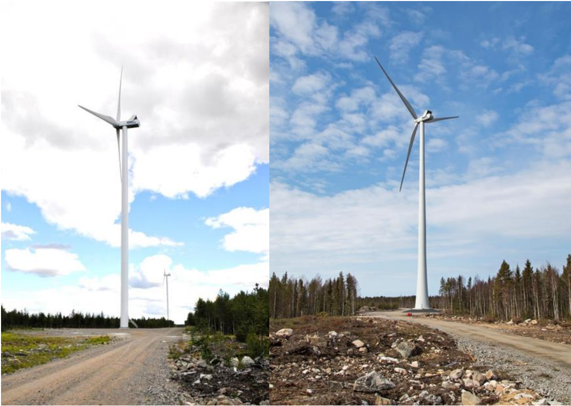
Kuva 67. Vasemmalla on esimerkki teräslieriötornista ja oikealla hybriditornista. (Kuvat: Leila Väyrynen ja Ville Suorsa, FCG)
